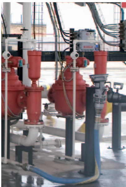
arriba: Detalle del nuevo brazo ligero, que permite hacer las purgas de los camiones cisterna de forma más sencilla y segura.
