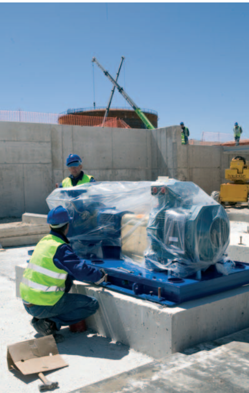
arriba: Lugar de emplazamiento de una de las bombas que servirán para impulsar el producto.
