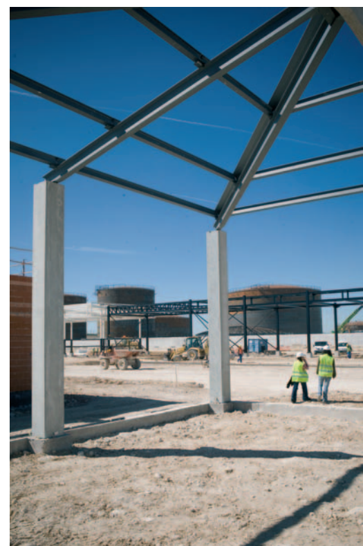
arriba: Los trabajos de construcción de una nueva instalación suelen durar cerca de dos años.
