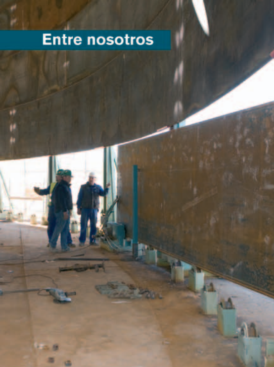
arriba: Colocación de una de las virolas que formarán la estructura de un tanque de almacenamiento
