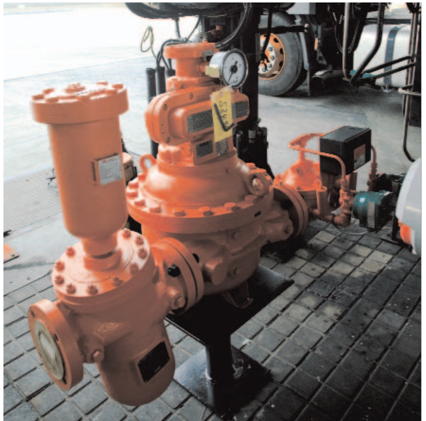
arriba: Medidor de cargadero específico para bioetanol.
