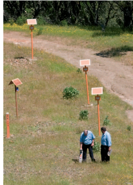
arriba: Operarios midiendo la profundidad del oleoducto.
